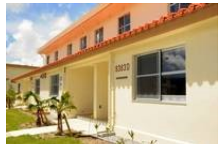
Renovierte Housing auf der Kadena Air Base (Foto: Cindy Fisher, S&S)
